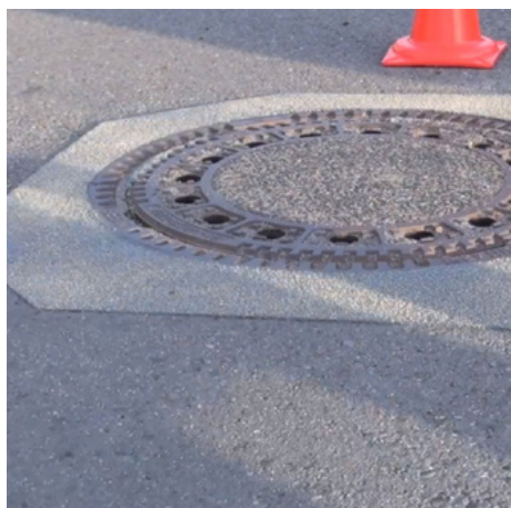
Gjutning och murbruk
