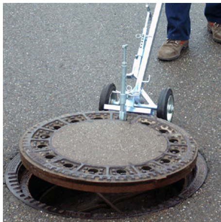
Оборудване на канали и шахти
