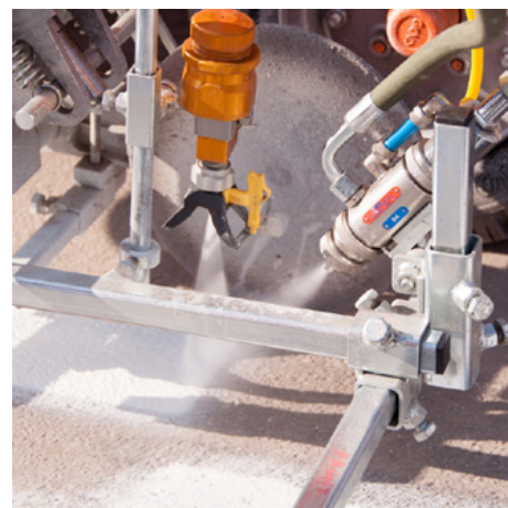
Kallsprutning av plast
