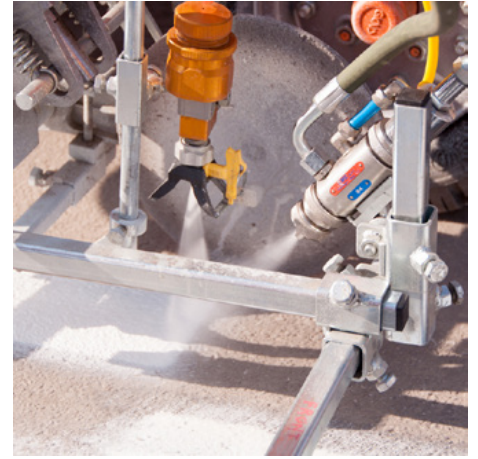
Kallsprutning av plast
