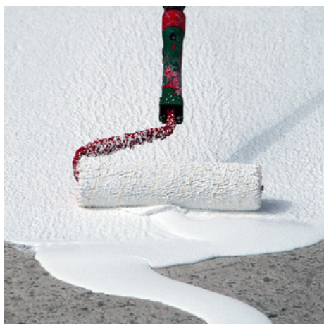
Cold műanyag felgöngyölítése
