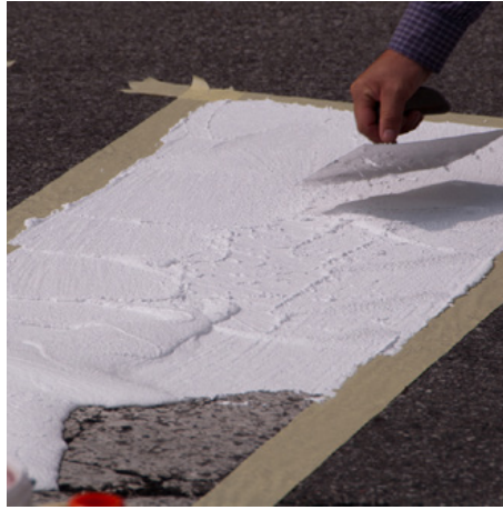
Plásticos frios para nivelamento
