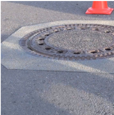
Gruģēšana un mūrēšanas java
