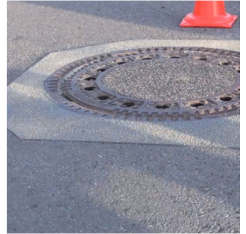
Verguss- und Mauer- mörtel
