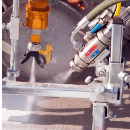
Tecnica di marcatura
