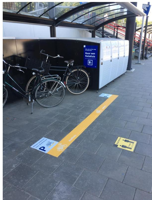
In Holland wurden Abstellflächen definiert, auf denen die Fahrräder nach der Verwendung abgestellt werden können. Die Kennzeichnung der Abstellflächen erfolgt mittels der patentierten Asphaltfolie. Diese bietet viele Vorteile gegenüber herkömmlichen Straßenmarkierungen und ist absolut sicher!
