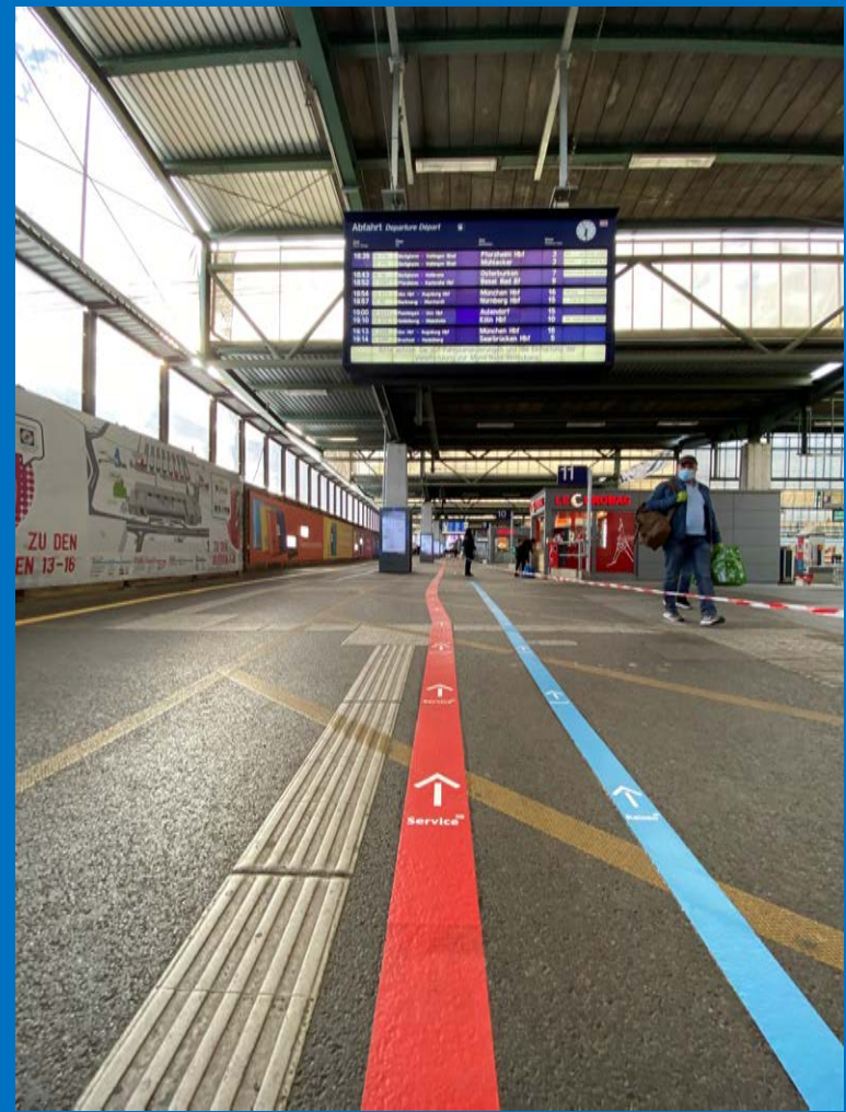
Bahnhof Stuttgart: Mit Asphaltfolie
