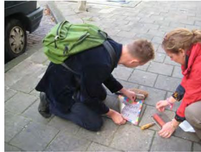
**Trägermaterial:** Es besteht nicht aus PVC, sondern aus Aluminium. Ein besonderer Vorteil, führt Andreas Schmich weiter aus, denn „die Asphalt Art - Asphaltfolie passt sich durch das Aluminium dem Untergrund nahezu nahtlos an – "es sieht aus wie gemalt“. Nach dem Druck kann die Folie sofort montiert werden. Ein zusätzliches Laminieren sei im Gegensatz zu anderen Produkten nicht nötig – Asphalt Art verfügt über die Rutschfestigkeit R 11; daneben ist sie B1-brandschutzzertifiziert.
