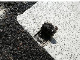
**5.** Das Material kühlt normalerweise innerhalb von 5–10 Minuten ab. Wenn das Material vollständig abgekühlt ist, kann eine Haftprüfung mit Hammer und Meißel durchgeführt werden. Eine gute Haftung ist erreicht, wenn Teile der Asphaltfläche an der Rückseite der Markierung haften (siehe Bild oben). Um die Abkühlung an heißen Tagen zu beschleunigen, mit etwas Wasser besprühen. Entfernen Sie überschüssige/nicht haltende Glasperlen nach abgeschlossener Applikation.
