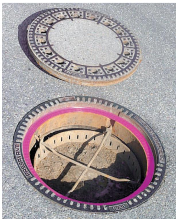
Die abgeschrägte äußere Stützkante zentriert den Deckel und verhindert horizontales Verschieben.
